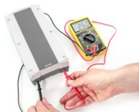
Kontrollera spänningen hos batteriet
